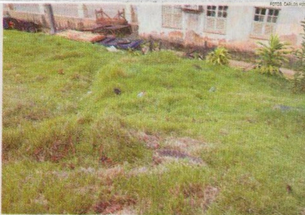
Buraco apontado pelo professor foi tamponado para evitar acidentes
