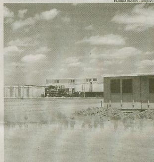
Prisão que está sendo construída em Craíbas também tem problemas
