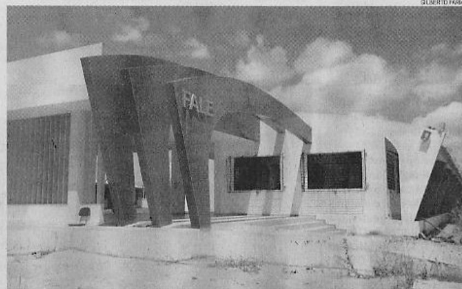
Servidores e alunos da Ufal afirmam que no prédio da Faculdade de Letras faltam iluminação e segurança.
