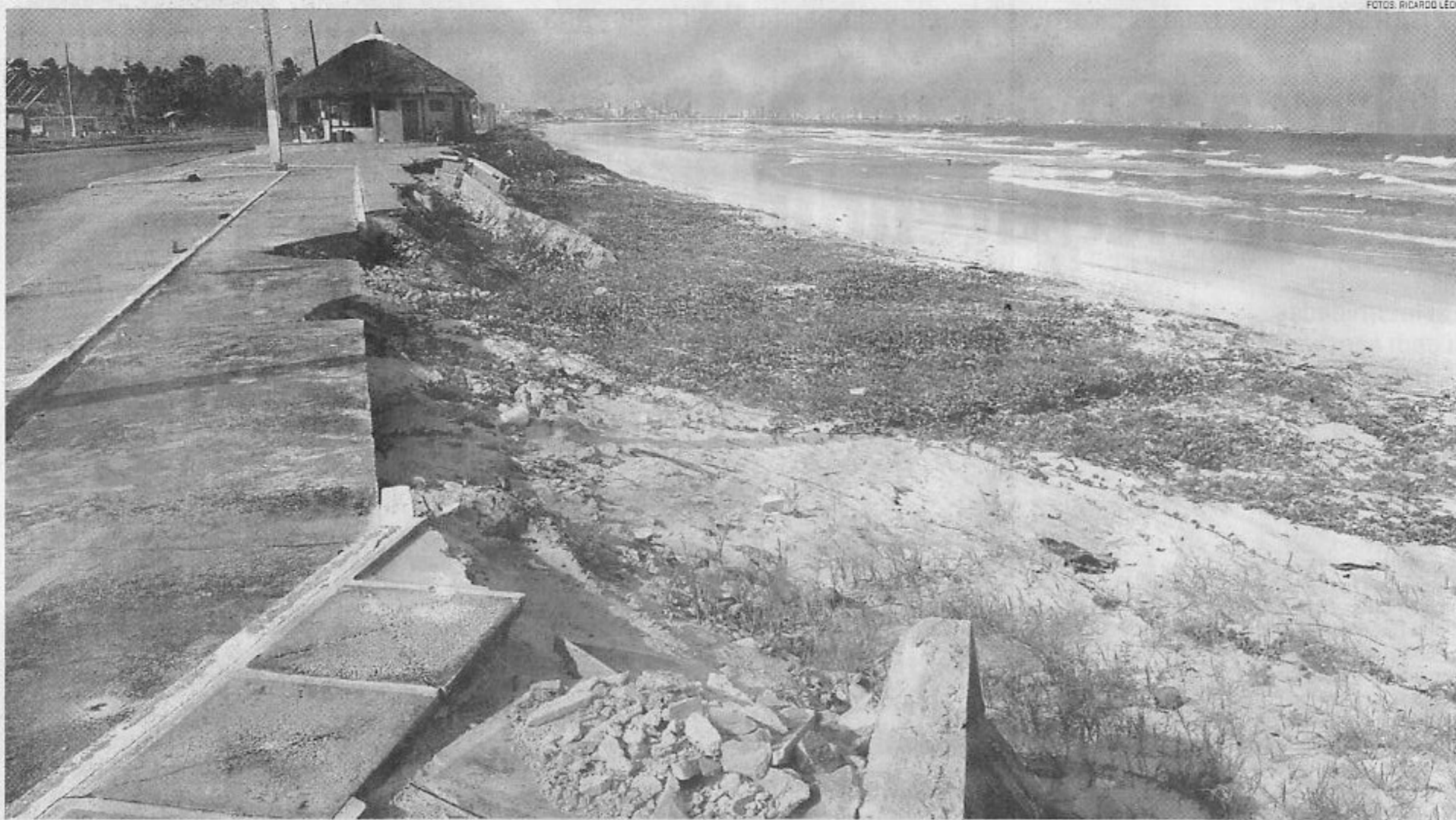
Um das regiões mais afetadas pelo problema é a do Pontal da Barra, onde as águas do mar já destruíram parte do calçadão da orla e ainda ameaçam atingir uma barraca à beira-mar
