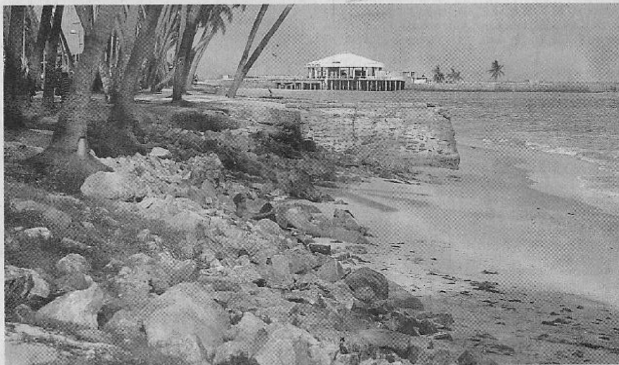
Na Ponta Verde, pedras foram colocadas para tentar barrar o avanço do mar em trecho onde faixa de areia já diminuiu bastante
