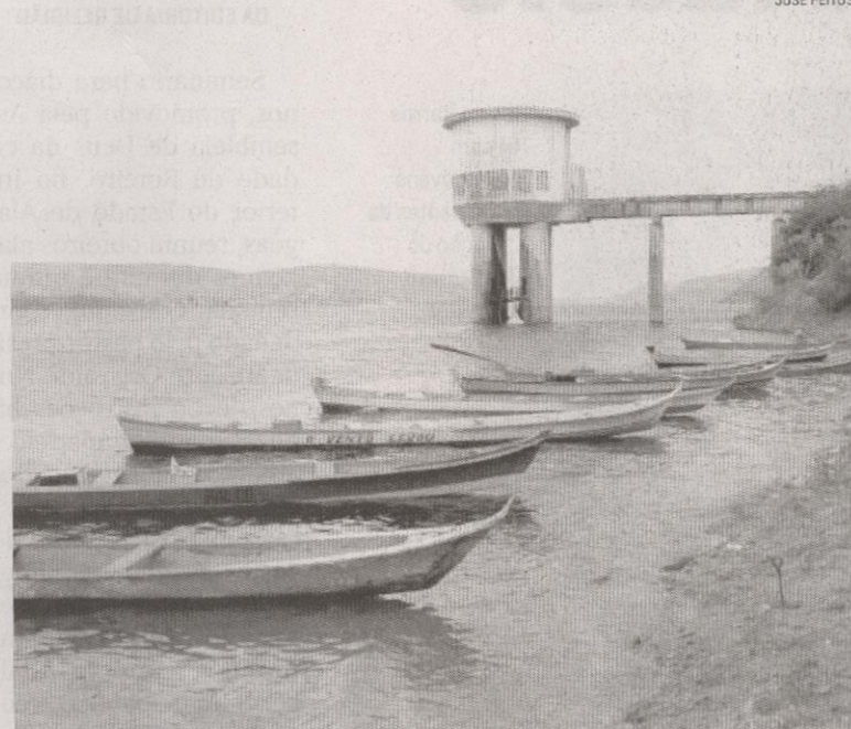
Com menor vazão, Casal será obrigada a avançar as bombas de captação da água para o leito do rio
