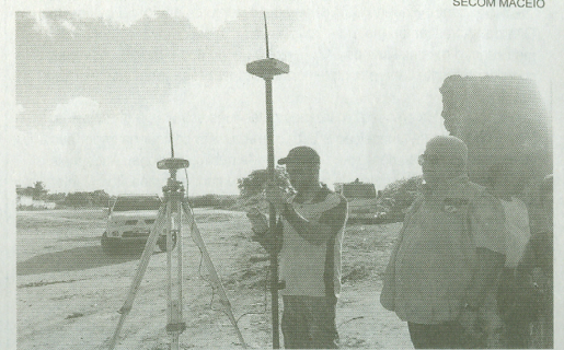
Técnicos fazem monitoramento da região com equipamentos diversos
